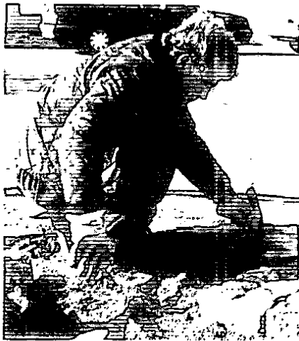
Abbildung 3: Entlastung der Kniegelenke durch Hockerstütze bei tiefen Bodenarbeiten.
